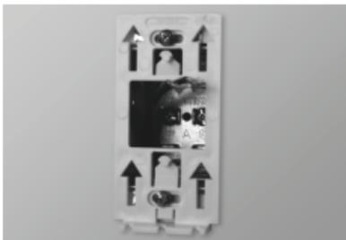
5. Faites passer les fils provenant du mur à travers le trou de la plaque murale et effectuez les raccordements électriques en utilisant les connecteurs sans soude fournis. Dans le cas d'un raccordement à des fils d'aluminium, assurez-vous d'utiliser des connecteurs identifiés CO/ALR. Veuillez noter que les fils du thermostat n'ont pas de polarité, et que le sens du raccordement n'a aucune importance.
