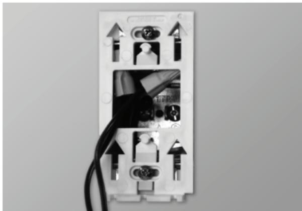
7. Alignez l'encoche située sur le dessus du thermostat avec celle sur la plaque murale. Enclenchez ensuite le thermostat dans la plaque murale en le glissant vers le bas, puis resserrez la vis à la base de l'appareil.
